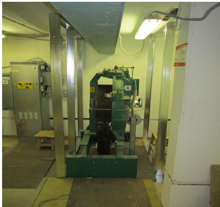
Кор.3, эт.35 Машинное отделение Устройство звукопоглощающего короба -устройство каркаса из профилей -заполнение каркаса минплитой
