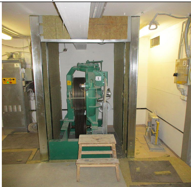
Кор.3, эт.35 Машинное отделение Устройство звукопоглощающего короба -устройство каркаса из профилей -заполнение каркаса минплитой
