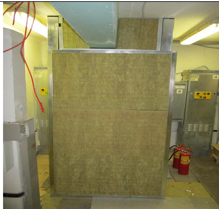
Кор.3, эт.35 Машинное отделение Устройство звукопоглощающего короба -обшивка каркаса листами ГКЛО
