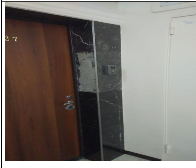
Кор.3, Сек.3 эт.12 Квартирный холл Восстановление откосов -укладка плитки и затирка швов
